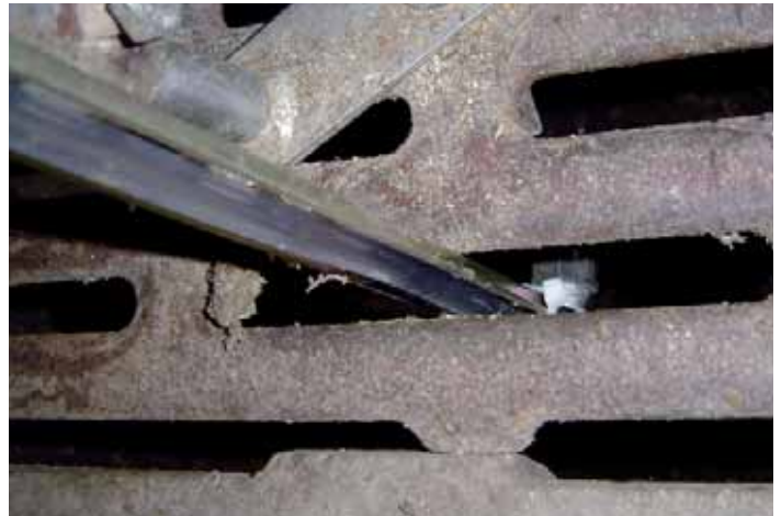
Abb. 3: Spray-Düsenkopf unterhalb des Spaltenbodens.
